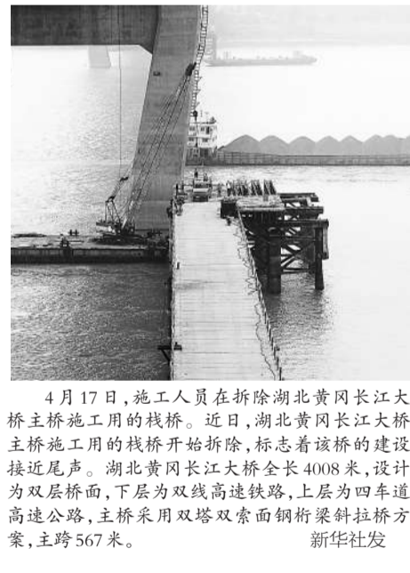
4月17日,施工人员在拆除湖北黄冈长江大桥主桥施工用的栈桥。近日,湖北黄冈长江大桥主桥施工用的栈桥开始拆除,标志着该桥的建设接近尾声。湖北黄冈长江大桥全长4008米,设计为双层桥面,下层为双线高速铁路,上层为四车道高速公路,主桥采用双塔双索面钢桁梁斜拉桥方案,主跨567米。
